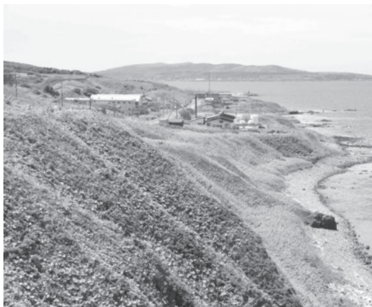
焼尻発電所(右)と焼尻小中学校 遠景は天売島
